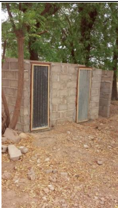
Les portes des 3 latrines ont été faites et posées.
